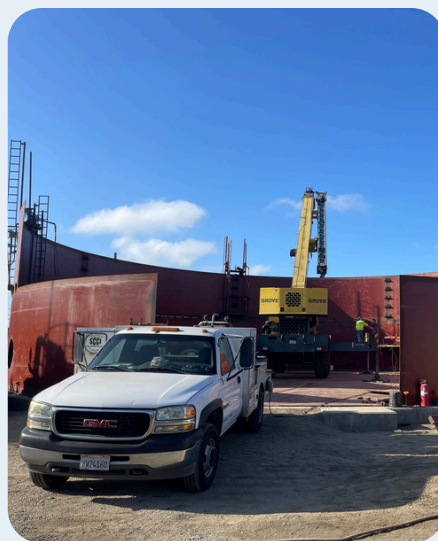
Pozo Armstrong N.º 2
