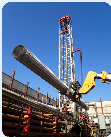
Reemplazo del Pozo Gage
